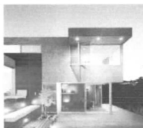
Exemplo de aplicação em fachadas de Porcelanato com textura de cimento queimado
